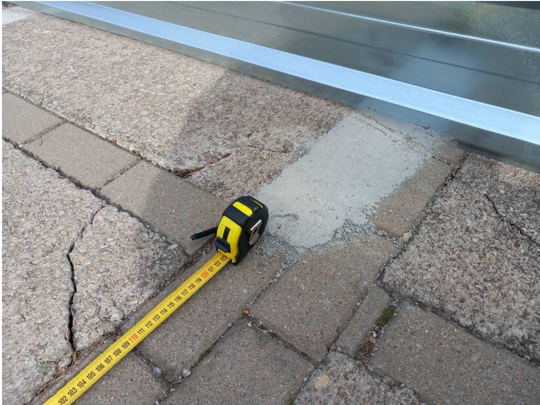
Rampa feta de morter per suavitzar el desnivell executada per JOCAMAR2016, SL.
