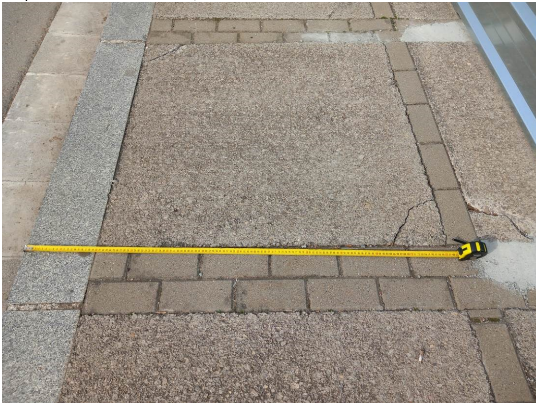
Amplada lliure de pas sense desperfecte: 1,20 m
