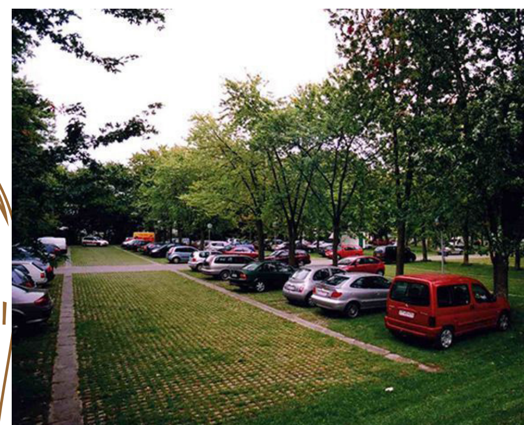
Paviments permeables i aparcaments verds
