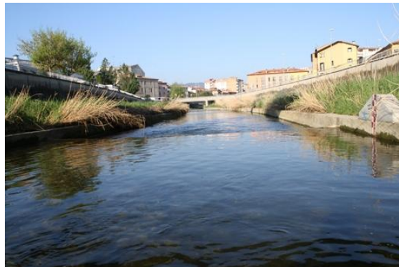
Figura 14. Riu Ges al nucli urbà de Torelló (Te33) on no hi ha bosc de ribera i tot el tram està canalitzat i formigonat.
