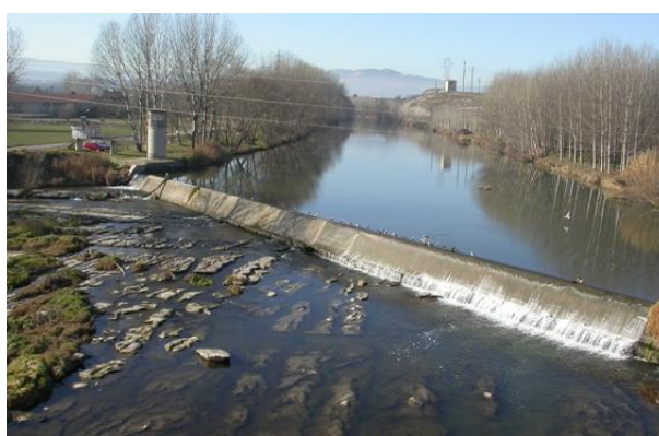
Figura 25. Resclosa de Roda de Ter, on es veuen els esqueis, un hàbitat massa homogeni, que no ofereix refugi suficient a la fauna per manca de còdols i graves aigua avall de la resclosa.
