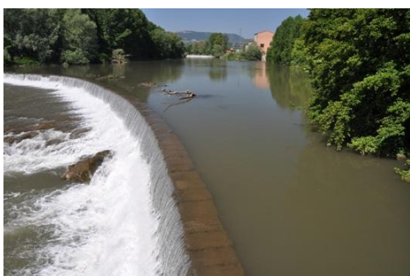
Figura 24. Resclosa de la Teula a Manlleu amb un hàbitat molt homogeni riu amunt amb molts còdols, graves i sediment acumulat aigua amunt de la resclosa.
