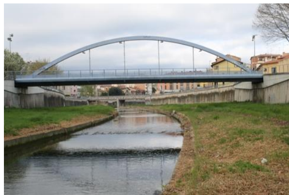
Figura 14. Riu Ges al nucli urbà de Torelló, amb tot el tram canalitzat i formigonat i ben poca vegetació de ribera, la primavera de 2016.
