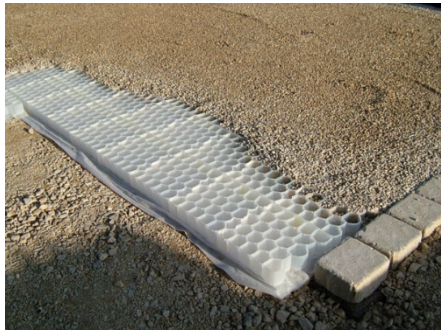
Geo-cel·la estabilitzadora d'àrids
