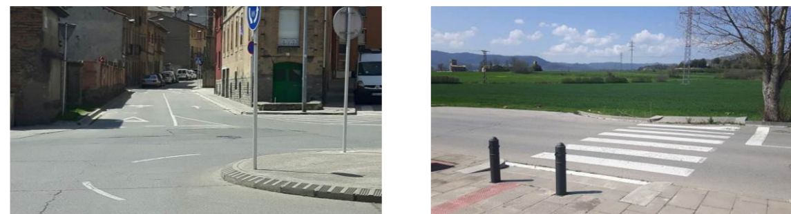
Pas de vianants inexistent c. de Sant Jordi amb rotonda (Els Caputxins)
