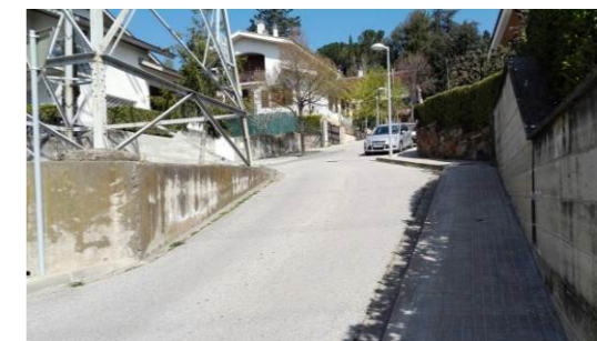
Tram de pendent > 6% Carrer del Pirineu (El Sucre)
