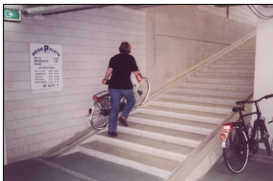
Figura 81: Escaleras habilitadas para subir y bajar con la bicicleta en La Haya, Países Bajos (BACC)
