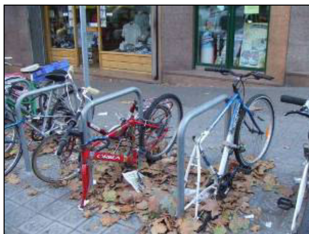
Figura 85: Mantenimiento inadecuado de un aparcabici (BACC)
