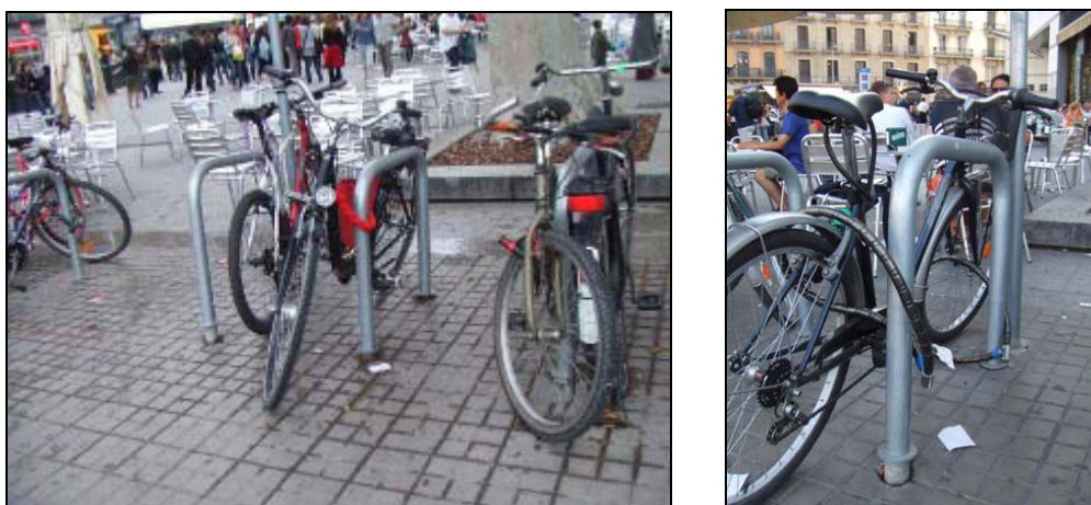
Figura 68: Mala fijación de los soportes (BACC)
