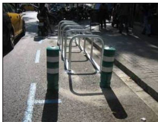
Figura 78: Aparcabicis en calzada con bolardos de protección (BACC)
