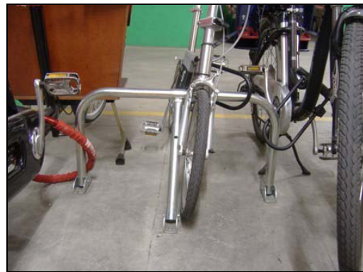
Figura 51: Aparcabicis familiar ocupando una plaza de coche, vista global y detalle del soporte (BACC)
