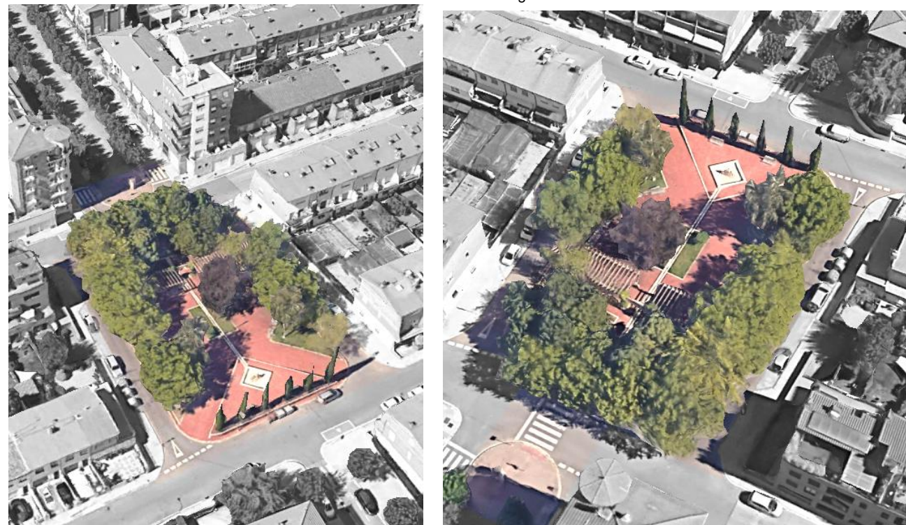
Vistes aèries de l'àmbit d'actuació des del costat nord (C. Bac de Roda) i des del sud de la plaça (C. Font de Sant Pere)
