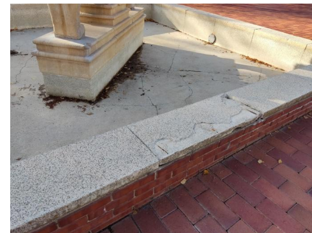
Generalment els elements realitzats amb adoquí ceràmic (Stradalit) es mantenen en bon estat, mentre que les peces de coronament de formigó blanc estan molt erosionades
