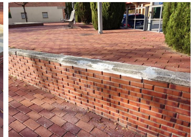
Generalment els elements realitzats amb adoquí ceràmic (Stradalit) es mantenen en bon estat, mentre que les peces de coronament de formigó blanc estan molt erosionades
