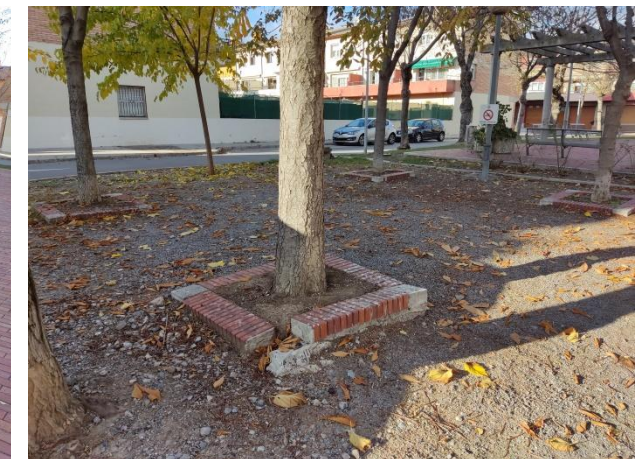
Escocell al voltant d'un castanyer
