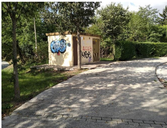
Estació transformadora en el gir del carrer Folgueroles
