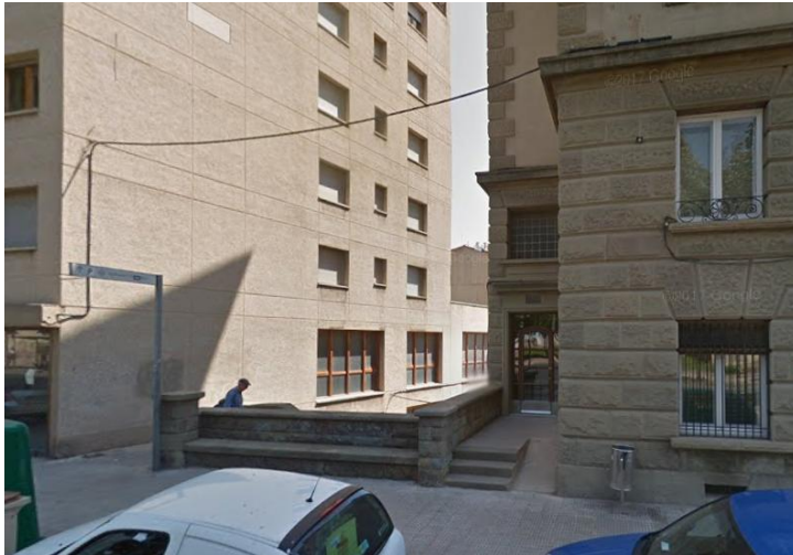
Vista des del c.de Mossèn Josep Gudiol, amb l'accés a l'edifici i les escales que connecten amb el c. dels Morató
