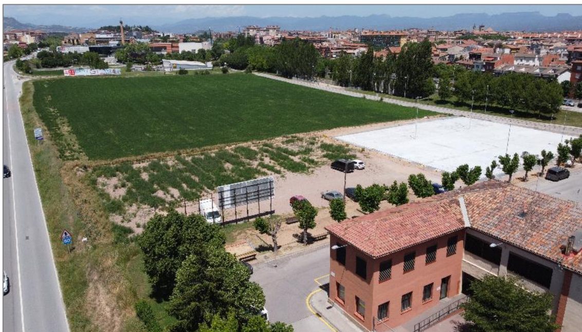
Fotografia 1. Vista general en sentit S-N de l'àmbit del sector PMU-06- Can Garrofa 2.
