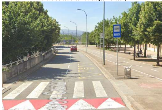
Parada de bus urbà Habitatges Montseny
