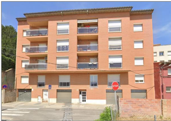
L'edifici del carrer de Sant Jordi 59
